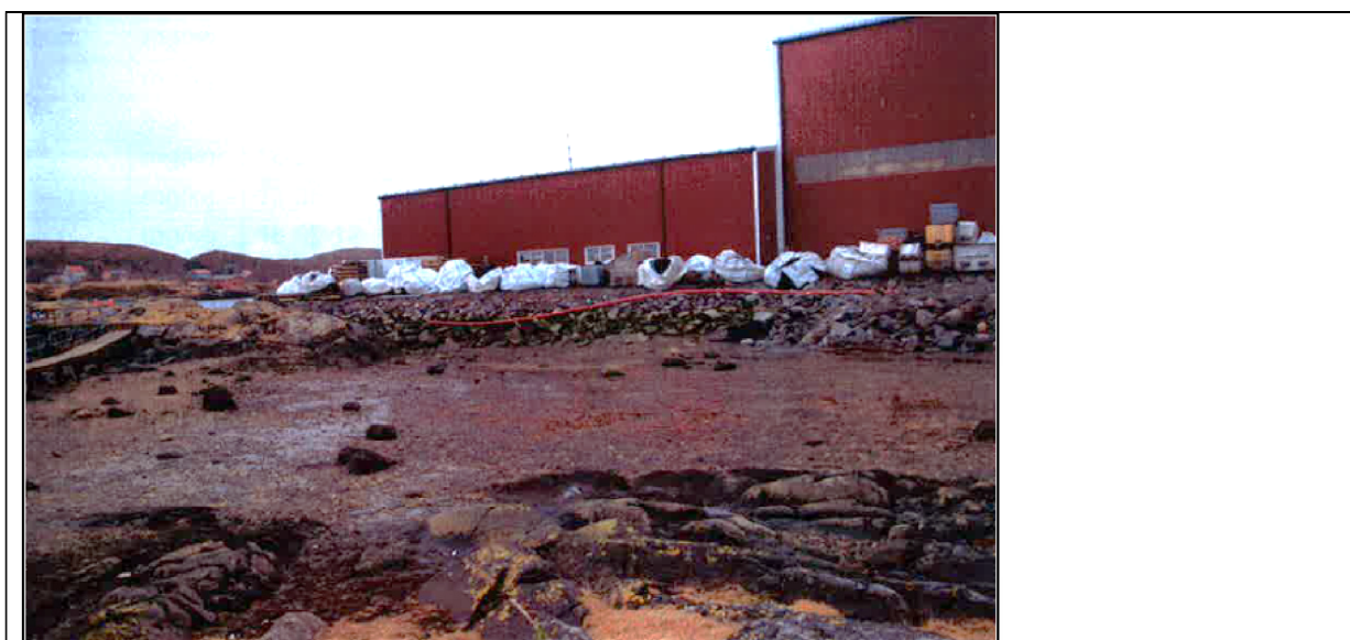
Figur 6. Grunnforholdene i området som skal fylles ut (foto: Mørenot v /Gullesen)
