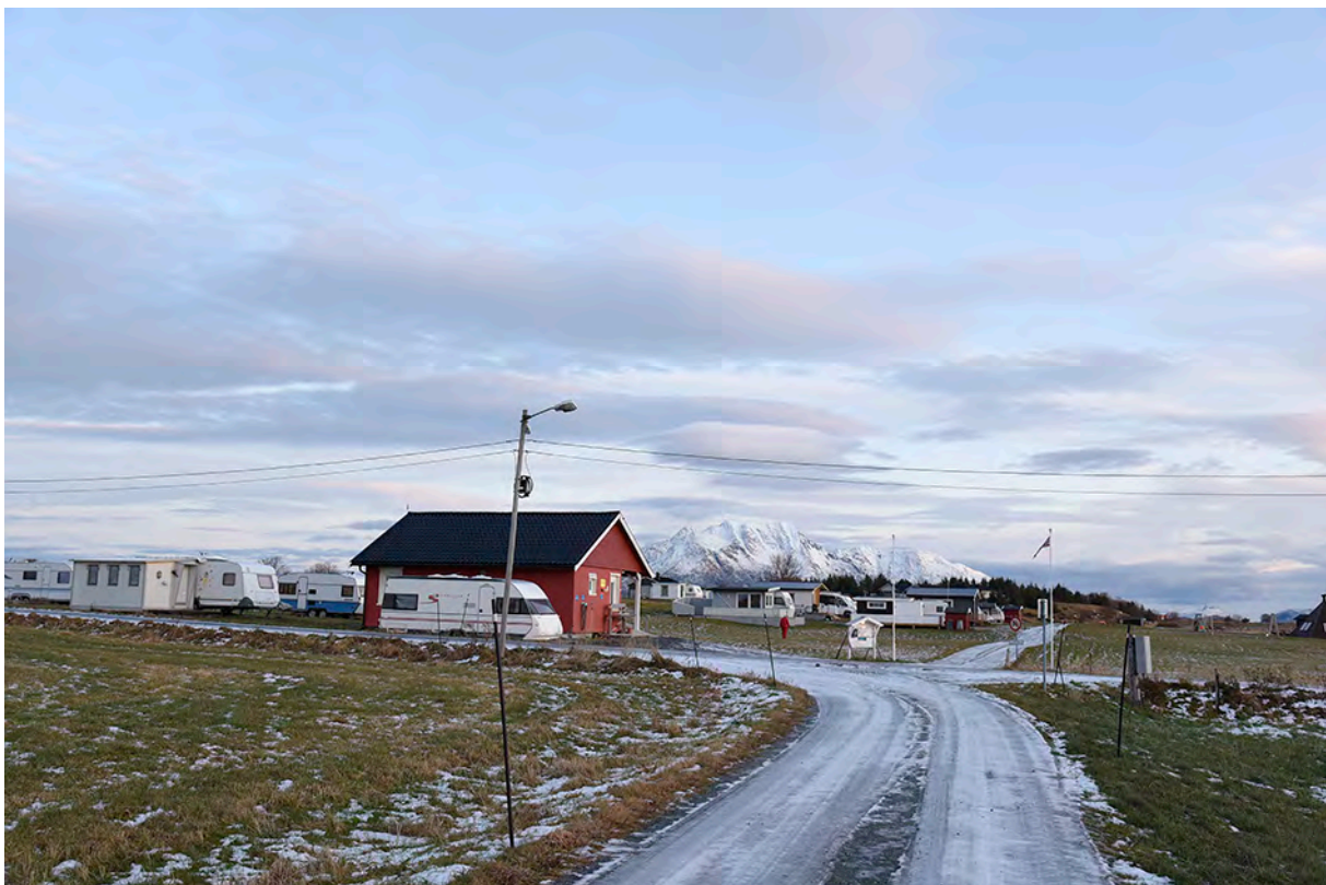
Foto 6. Campingplassen og servicebygget.
