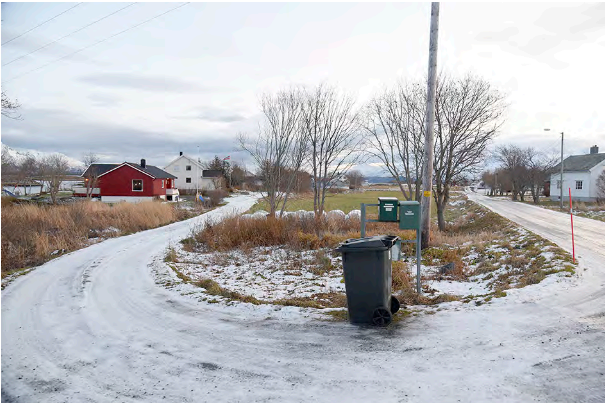
Foto 4. Bildet viser avkjøringen fra Tennveien, Fv7276, og ned til bebyggelsen som ligger ut mot Tennsundet.
