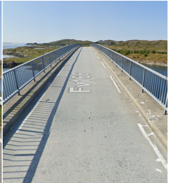
Figur 6: Sikt på midten av Øksningan bru fra Hestøya i retning Kalvøya (Google maps 2019).
