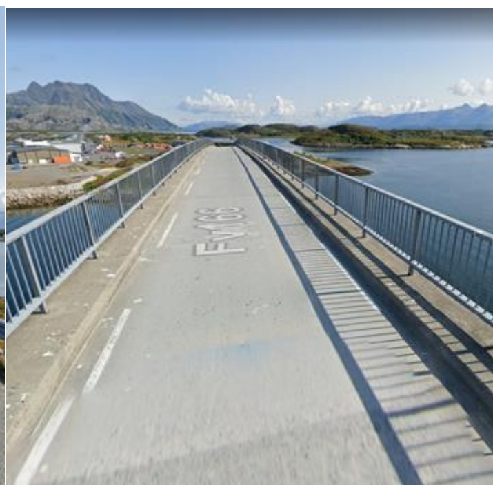
Figur 4: Sikt på midten av Øksningan bru fra Kalvøya i retning Hestøya (Google maps 2019).
