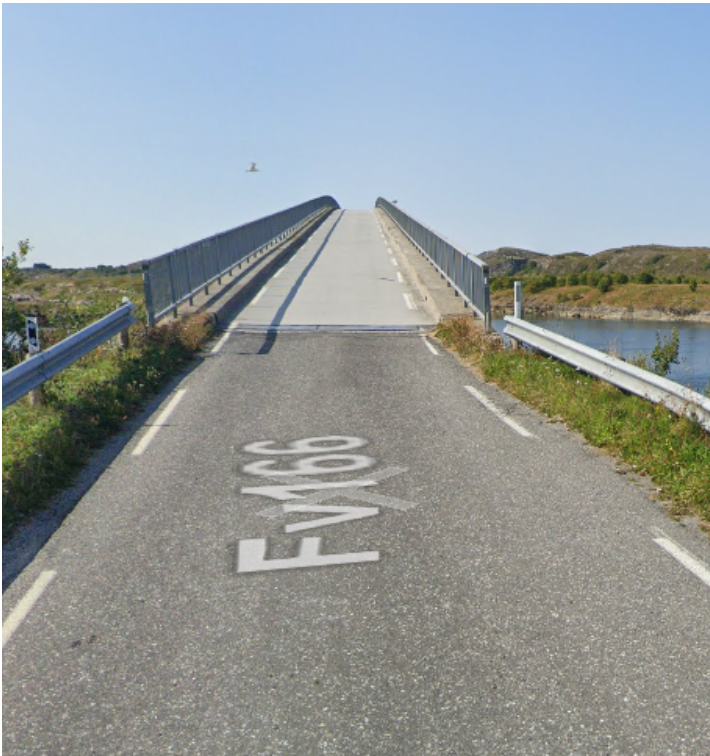
Figur 5: Innkjøring mot Øksningan bru fra Hestøya i retning Kalvøya (Google maps 2019).
