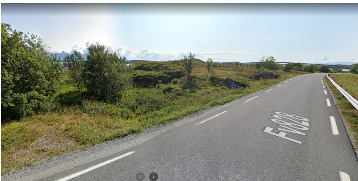
Foto 9. Bildet er tatt mot sør og viser planområdet på Skardsøya til venstre i bildet. Foto: Google maps.
